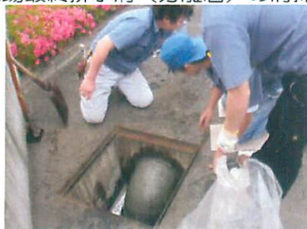
工場最終排水溝（分離層）の清掃
